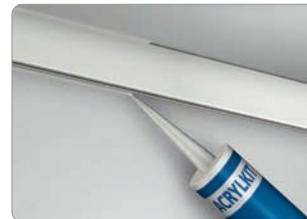
Zwecks Bearbeitung mit Kit entsteht eine nahtlose Einheit zwischen Schiene und Wand
